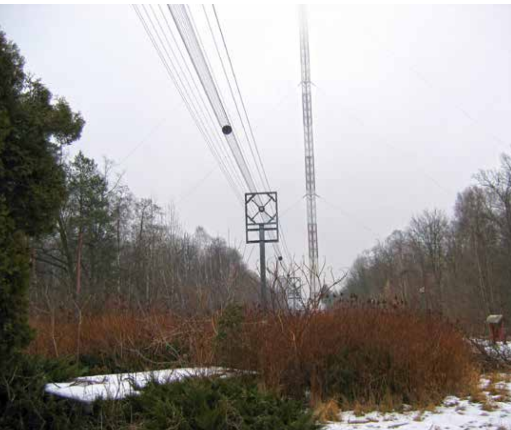
Maszty radiowe w Raszyńcu
