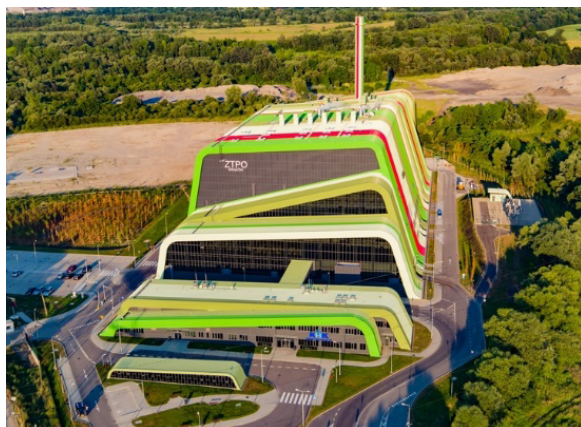
Ilustracja I.9. Zakład Termicznego Przekształcania Odpadów w ZSGOK
