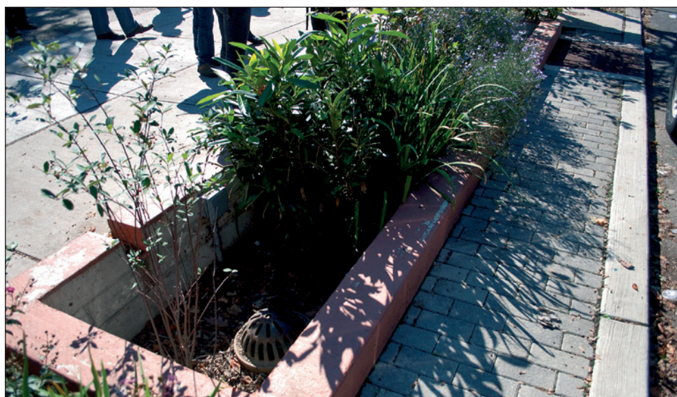
Rys. 2. Ogród deszczowy w gruncie rozdzielający jezdnię od ciągu pieszego, jednocześnie odbierający wodę deszczową z tych obiektów (fot. Leonel Ponce, Flickr; www.flickr.com/photos/leonizy/6233353514 , CC BY-NC 2.0)
