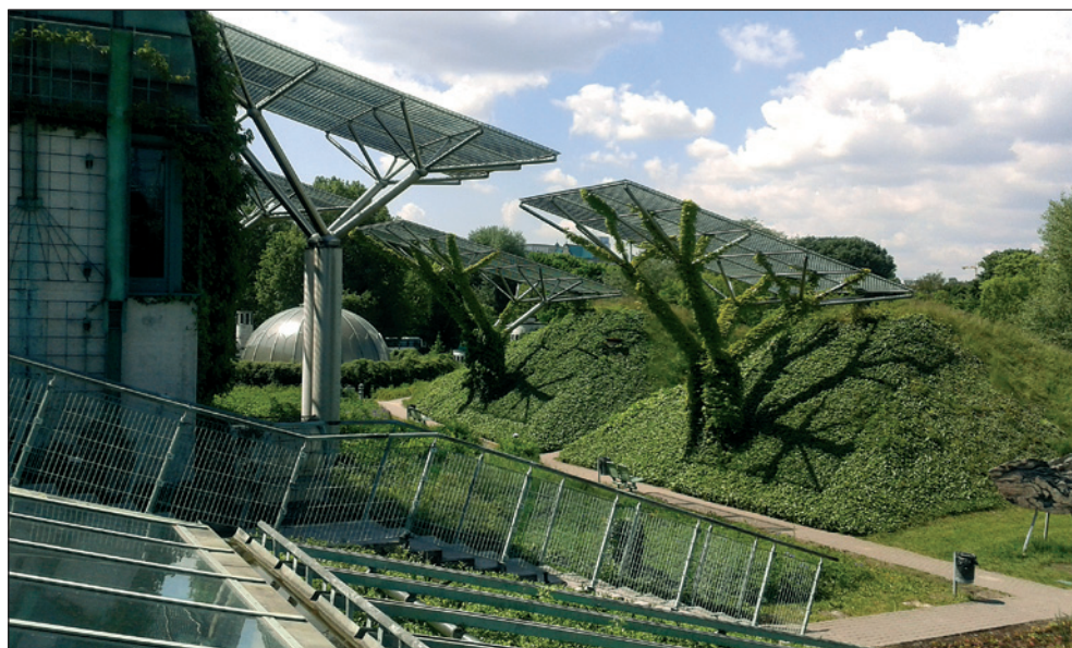
Rys. 18. Ogród na dachu Biblioteki Uniwersytetu Warszawskiego (fot. N. Żurkowska)
