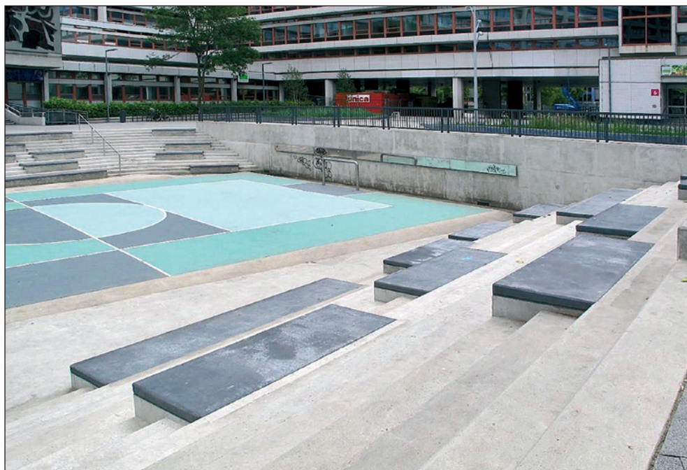
Rys. 8. Widok na część centralną placu – boisko, zamieniające się w zbiornik otwarty na deszczówkę w przypadku długotrwałych, intensywnych opadów i przepelnienia się wszystkich pozostałych elementów systemu (fot. Maria Matos Silva, CC BY-4.0, Silva i Costa 2018)
