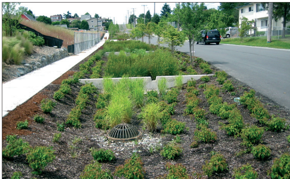
Rys. 11. Przykład muldy chłonnej obsadzonej roślinnością rodzimą
