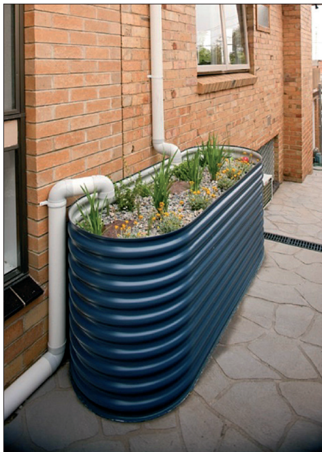
Rys. 9. Ogród deszczowy w pojemniku, Łódź
