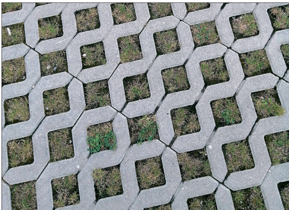
Rys. 1. Przykład zastosowania nawierzchni perforowanych na parkingu (fot. E. Wojciechowska)
